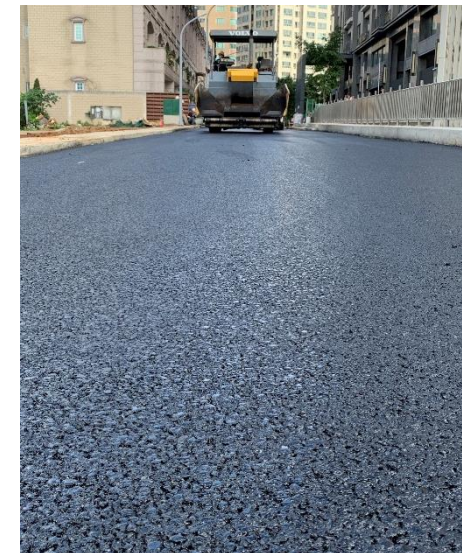
透水瀝青混凝土 施工完成面
