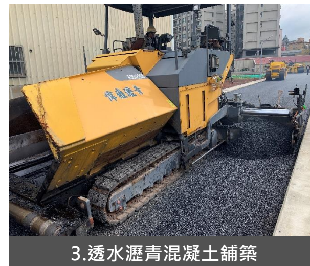
透水瀝青混凝土 施工完成面
