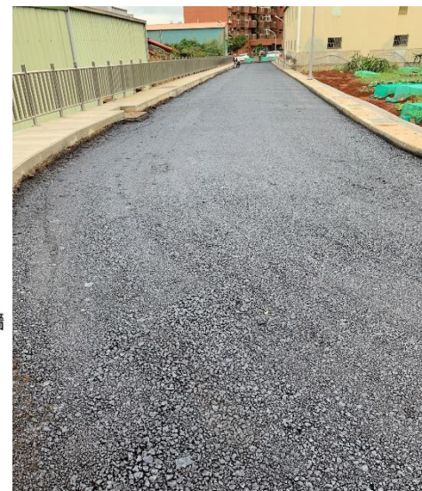
透水級配料 施工完成面
