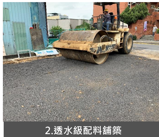
透水級配料 施工完成面
